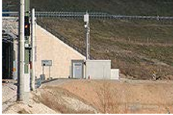
الشكل (١١) مرسل GSM-R لخطوط عالية السرعة
