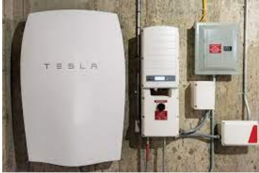
الشكل (٥) صورة لبطارية Powerwall لشحن السيارة في المنزل
