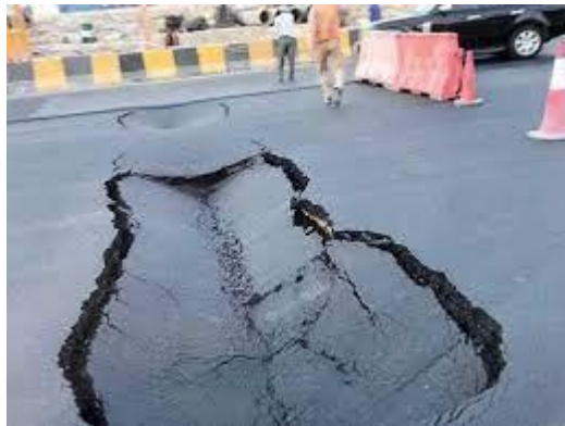
الشكل يوضح مثال عن الهبوط في الطريق
