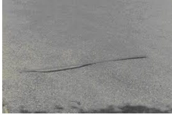
الشكل يوضح نموذج عن التقعر في الطريق
