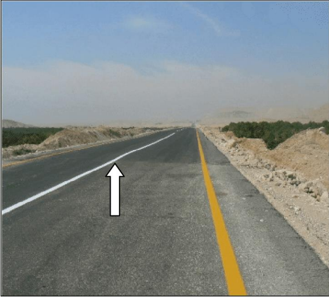
الشكل يوضح مثال عن انتفاخ في الطريق
