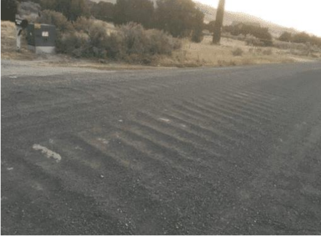
الشكل يوضح نموذج عن التموج في الطريق
