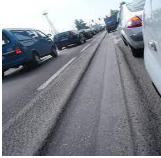
الشكل يوضح مثال عن التخذد في الطريق
