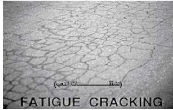
الشكل يوضح مرحلة نمو التشققات
