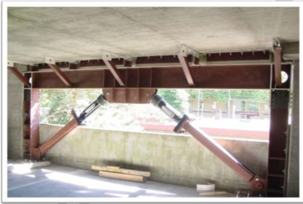
الشكل 7-1 شبكات التثبيت الممنوعة من التحنيب BRB
